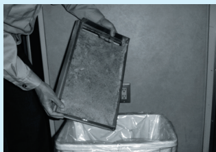
油吸着材の交換
